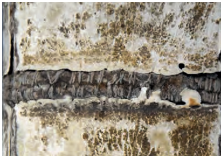
7.36. Detailní pohled na vaz bloku, který byl našíván systémem tzv. šití ob-složku (sign. I.F.4). 263
