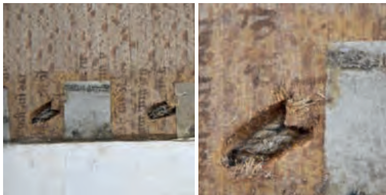
8.43. Žlábký pro vedení vazů na přídešti desky vedené šikmo – celkový pohled a detail (sign. XXII.G.β.39). 363
