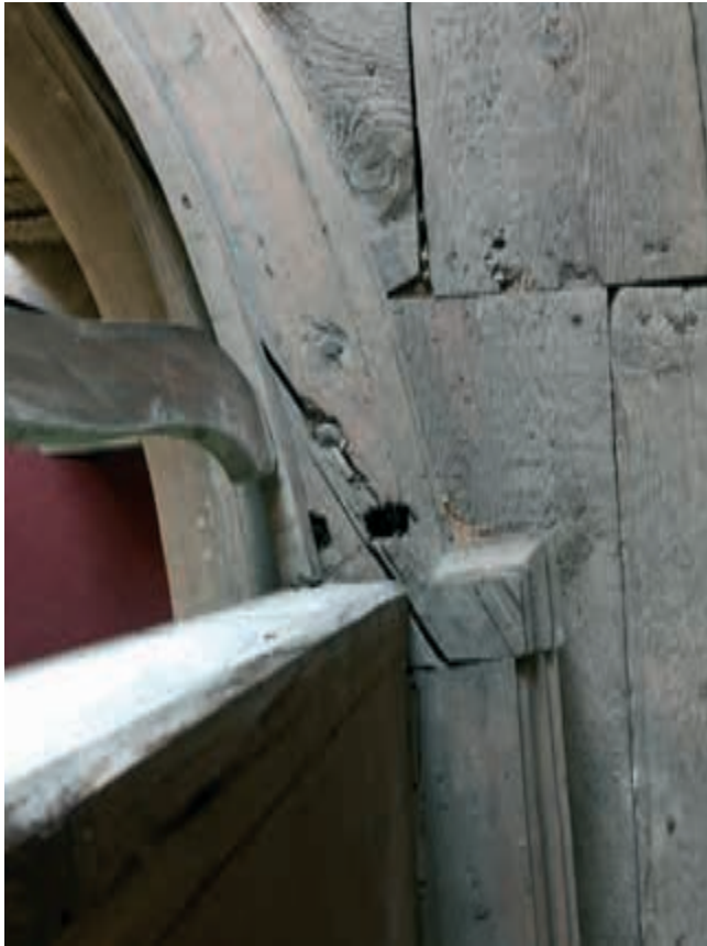
Galerie, Einsatzstutzen der ursprünglichen Galeriebrüstung.
