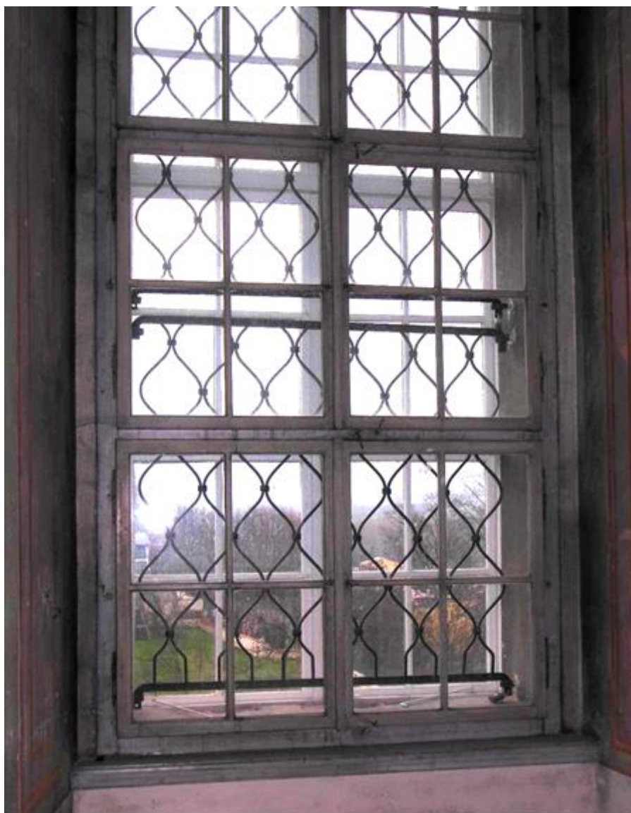
Obr. 17. Klášter Broumov – knihovni sál, řešení zabezpečení oken sálu vyjímatelnými mřížemi, jejichž řešení je částečně inspirováno zjednodušeným barokním tvaroslovím. Z hlediska památkové péče jde o kompromis. Vyjímání mříží, aby se poblebově neuplatňovaly, je v provozní realitě objektu prakticky vyloučeno. Podoba detailů (např. prefabrikované visací zámky) je nevěrohodná. Foto: Sixtus Bolom-Kotari (2016).
