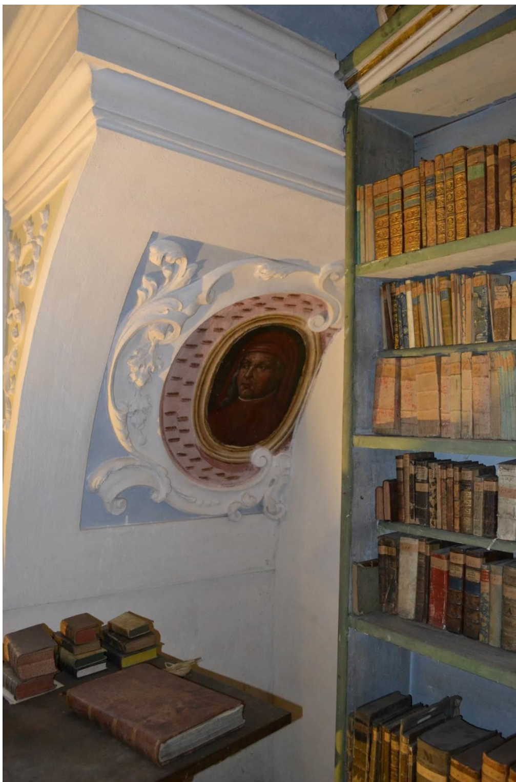
Obr. 9. Klášter Broumov, galerie knihovního sálu – příklad vrstvení (často prvoplánově rozporuplných a ne příliš citlivých) historických zásabů, zde z důvodů potřeby dodatečné instalace knihovního regálu. Posloupnost a kontext zásabů mapuje (před)restaurátorský průzkum. Foto: Zdeněk Zabradník (2019).
