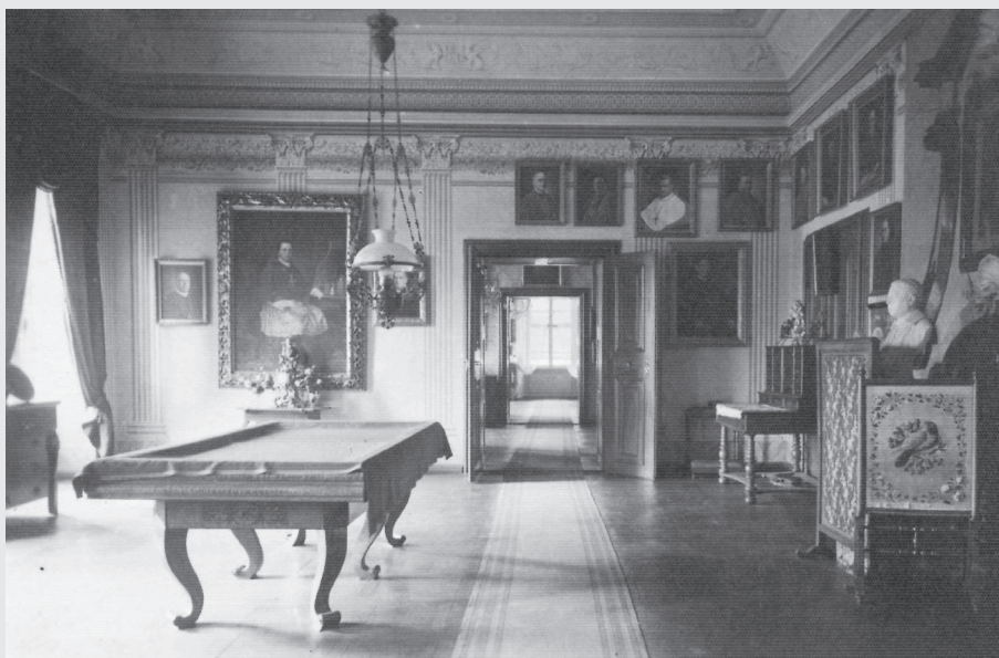
24. Interiér prelatury - tzv. kulečnickový sál, nedat.
